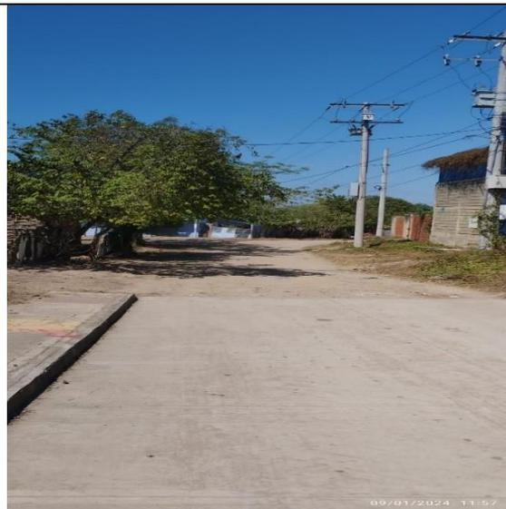
La vía esta completamente destapada, presenta hundimientos y no posee una capa de rodadura uniforme, alineamiento y bombeo deficientes.
